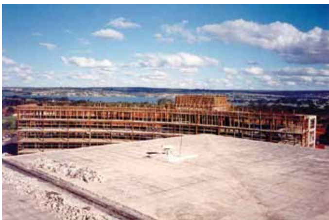
Figura 18 – Detalhe da cobertura de uma construção
