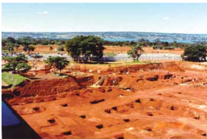
Figura 7 – Vista da locação de uma obra pública
