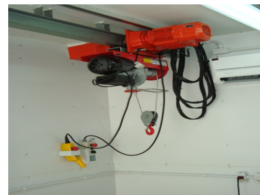
Ponte com talha móvel na longitudinal
